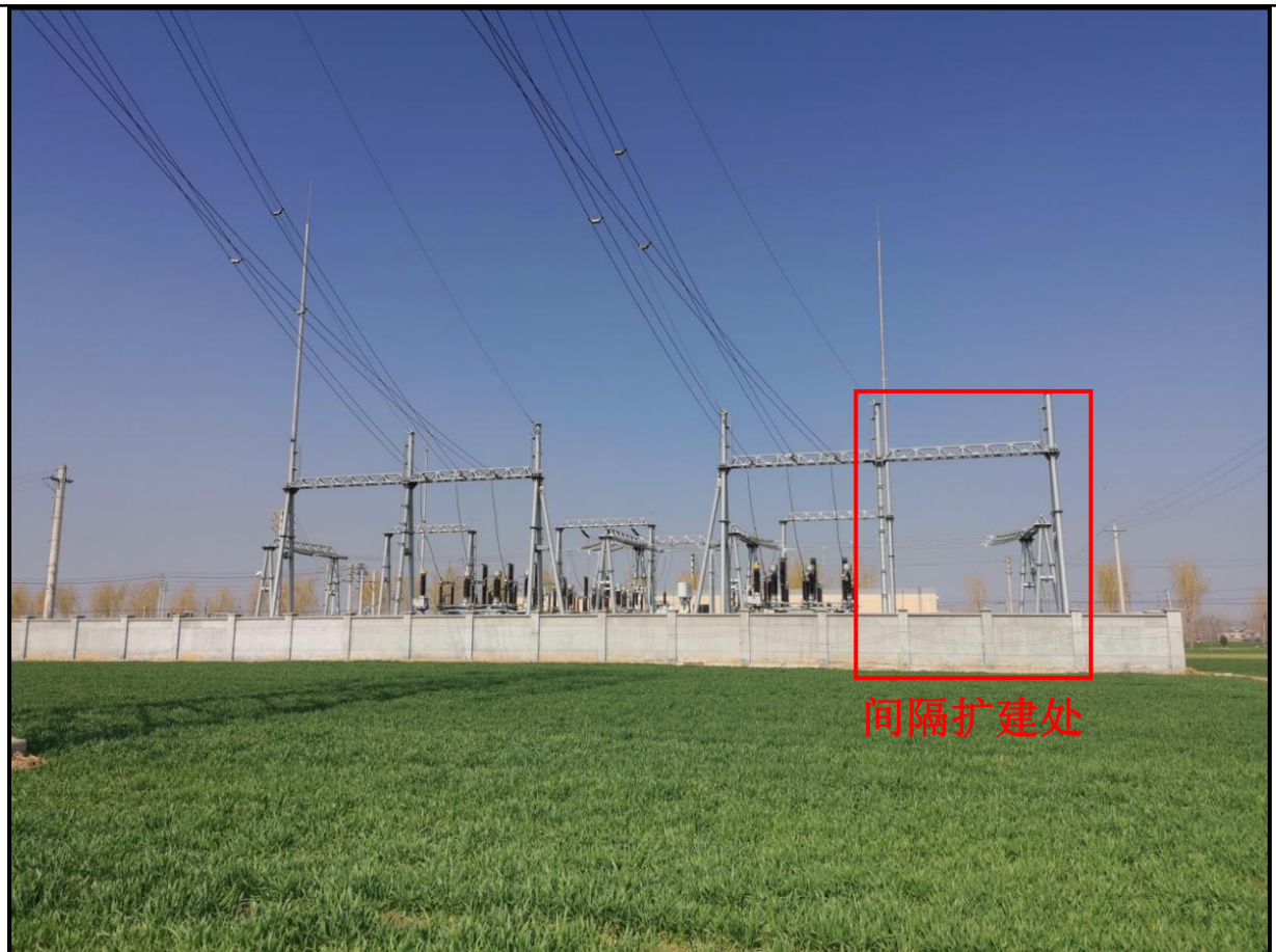
图 1-6 110kV 瑞祥变电站间隔扩建处现场照片
