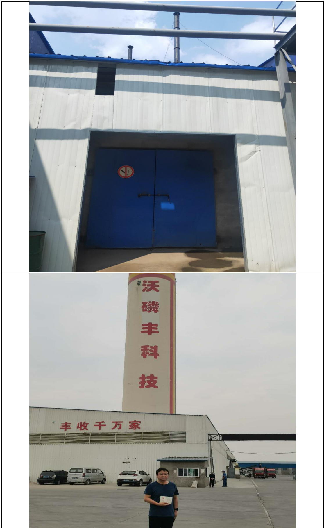
附图 4：现有锅炉房照片
