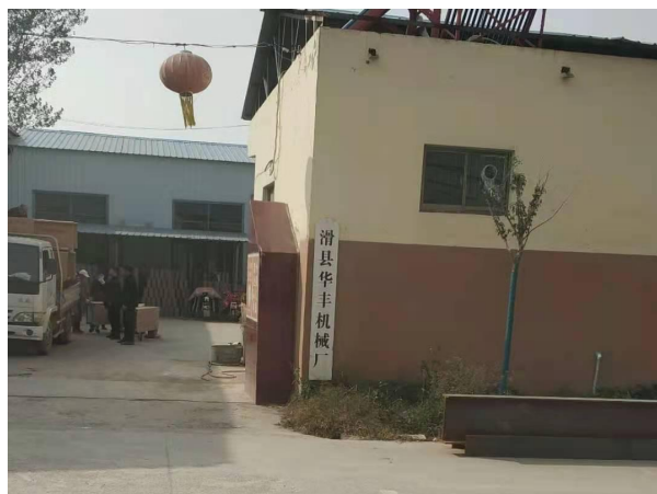
项目西侧的华丰机械厂
