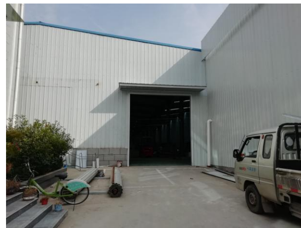
厂区现状（地面已硬化）
