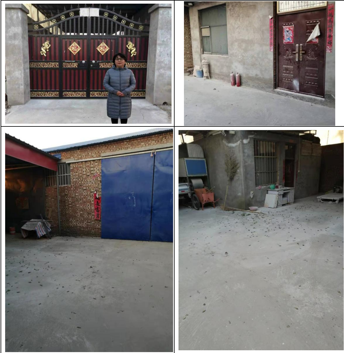
附图四 现场勘察图片
