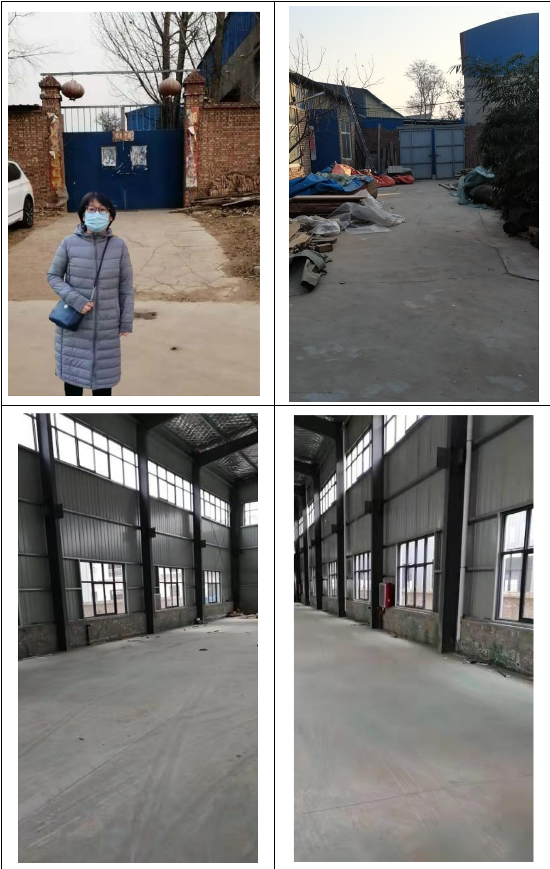
附图四 现场勘察图片
