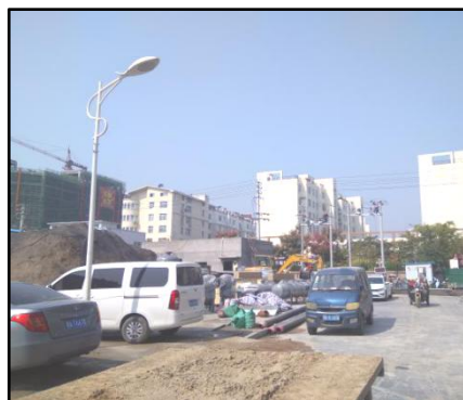
西侧祥泰苑小区现状
