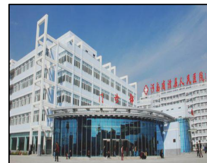
东侧院区现状照片
