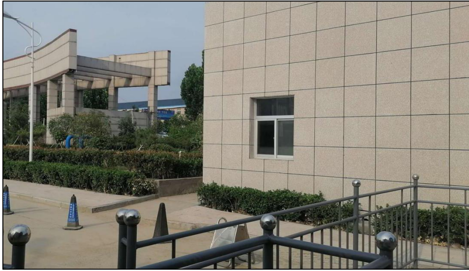
现有污水处理站地上设备间
