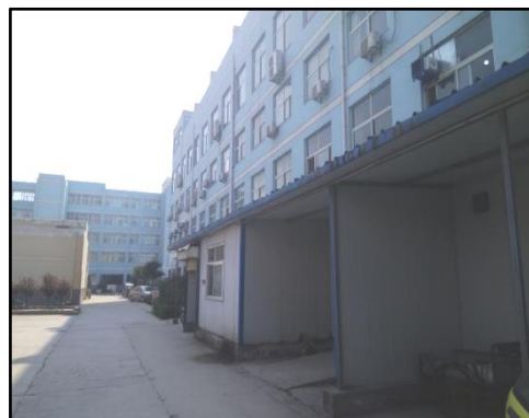
南侧院区现状
