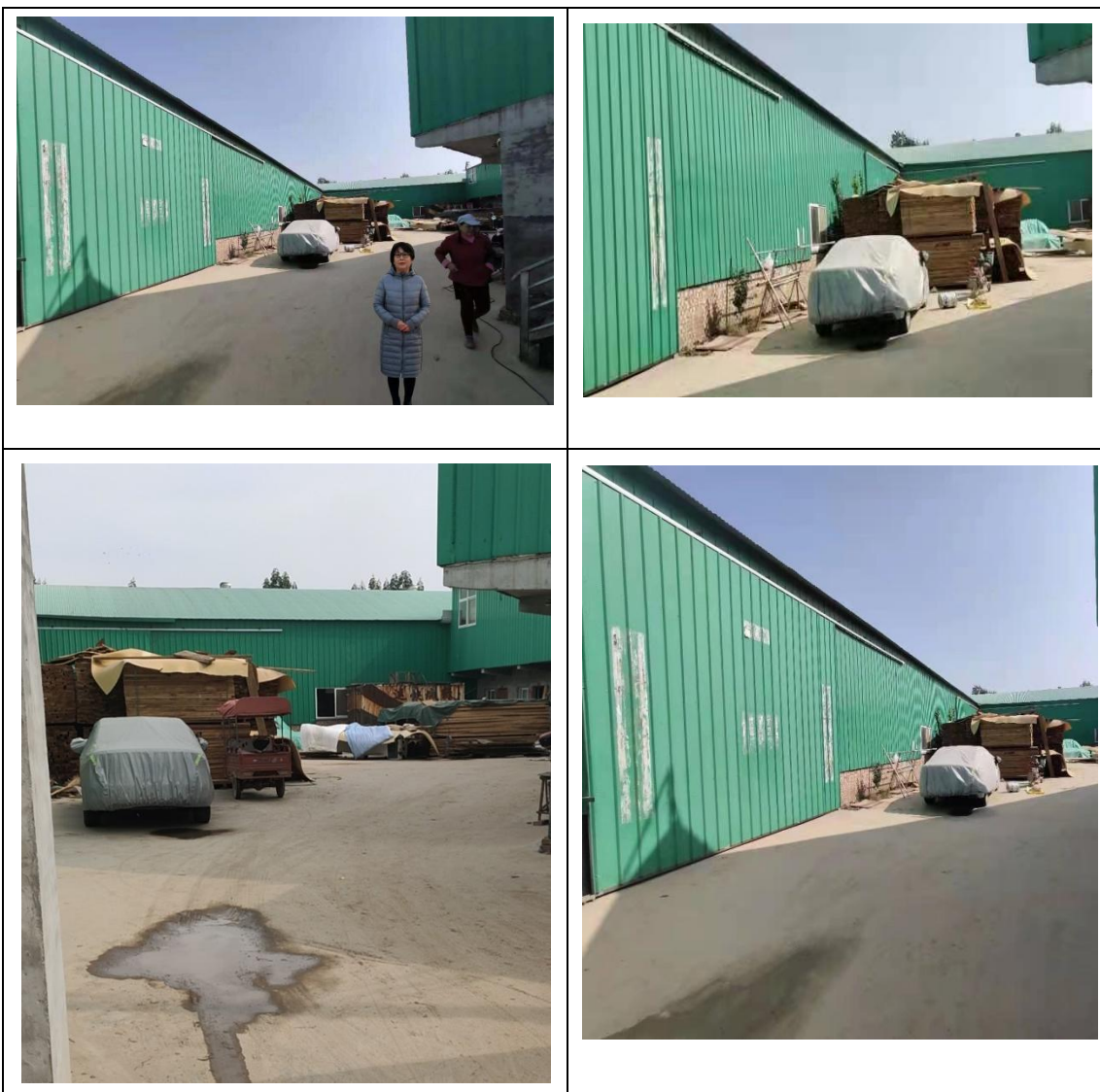
附图四 现场勘察图片
