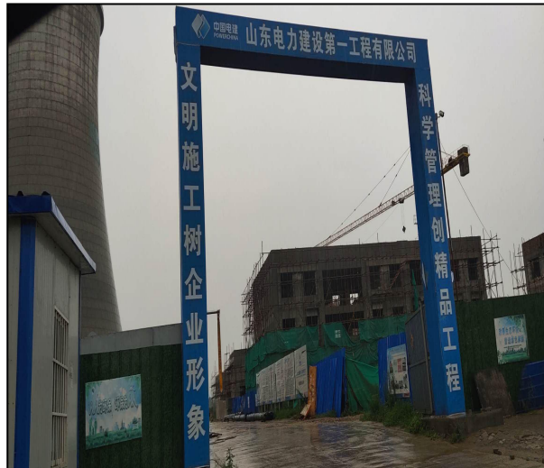
项目厂区电厂现状
