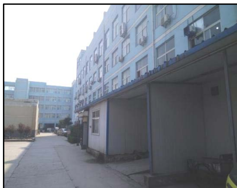
南侧院区现状
