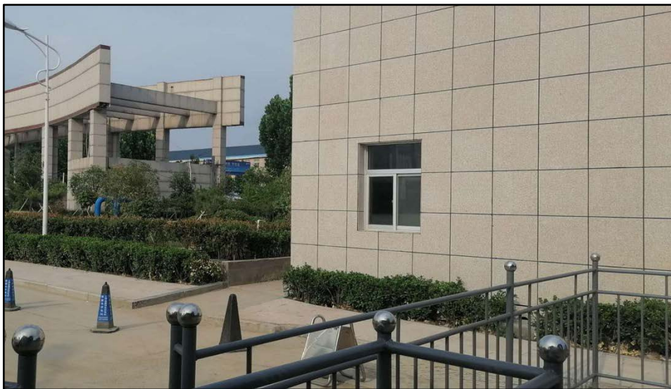
现有污水处理站地上设备间
