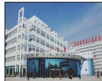
东侧院区现状照片
