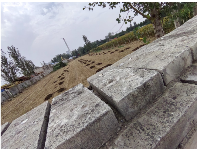
项目西侧：空地
