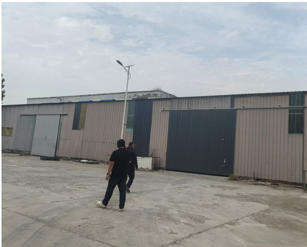
本项目租赁厂房现状
