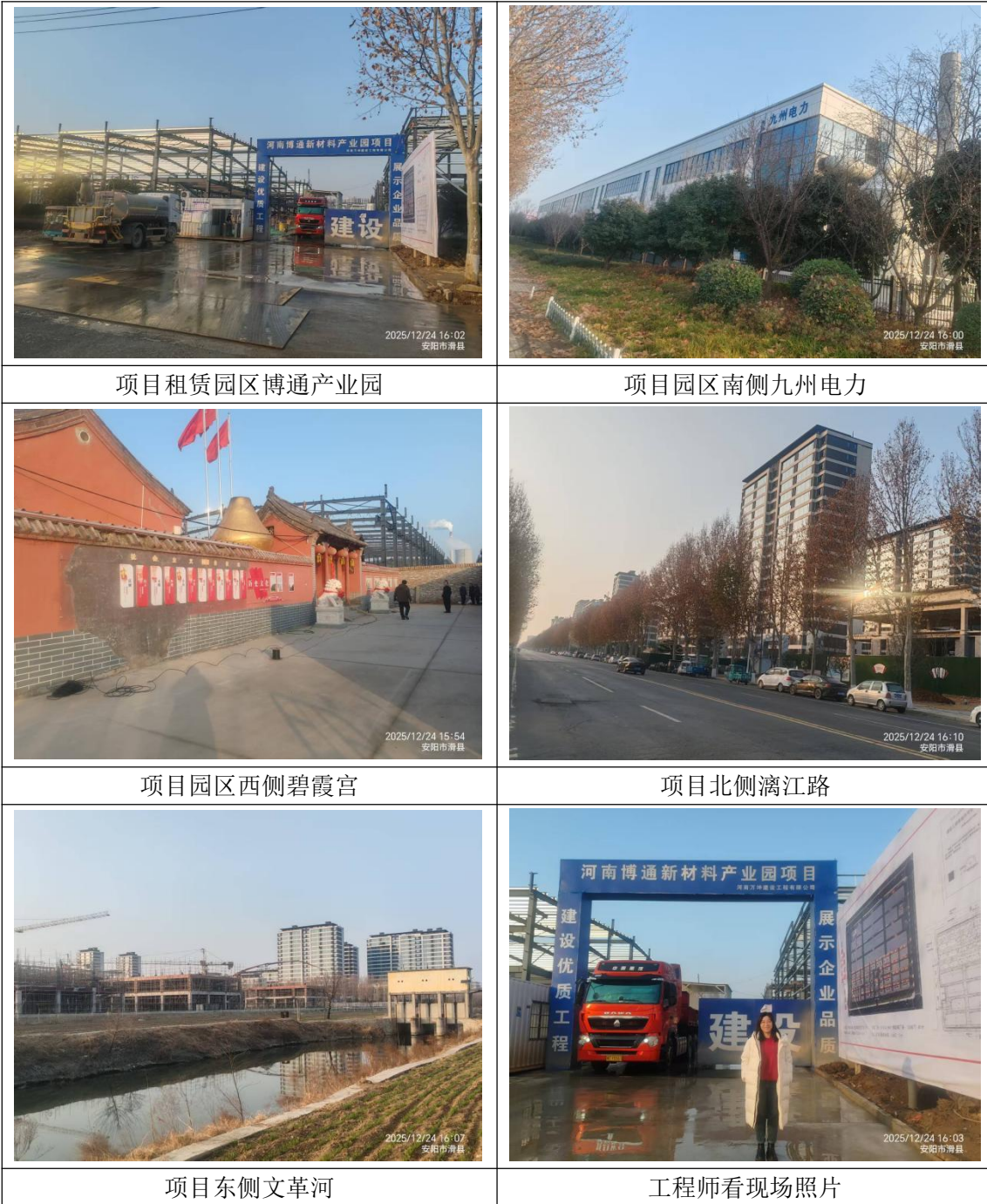
附图 12 项目现场照片
