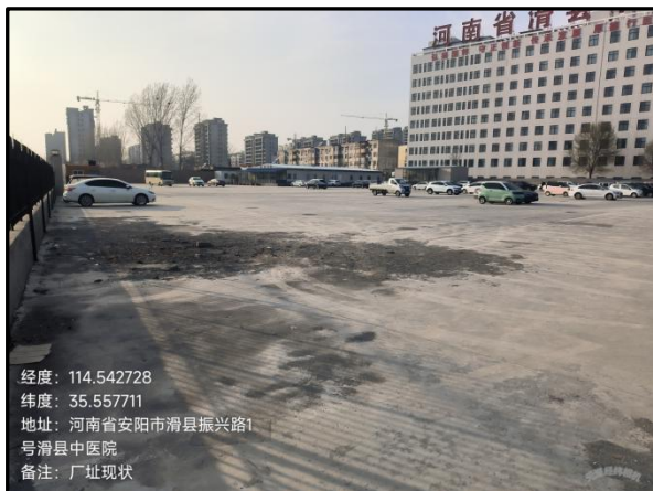
本次扩建工程现状
