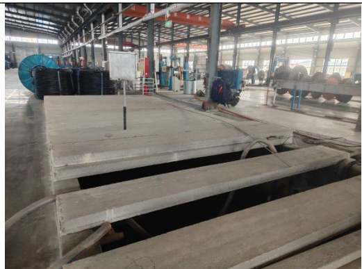
现有工程循环冷却水池
