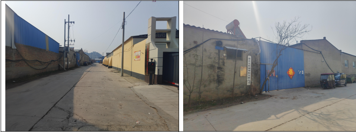
厂区东侧道路
