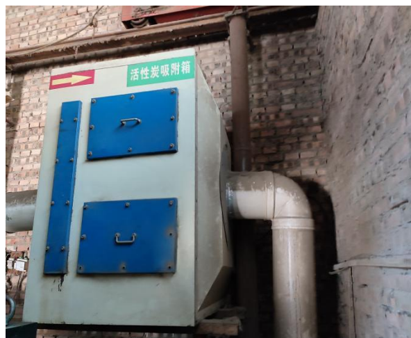
现有工程挤出工段配备的“UV 光氧催化+活性炭吸附装置”
