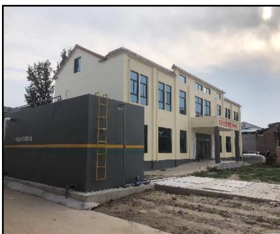
东安村污水处理站（村委旁）
