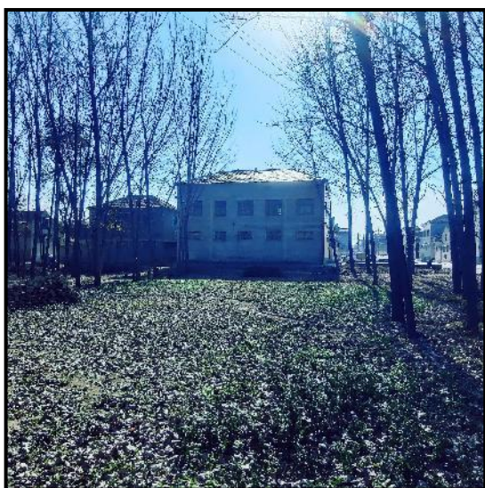
项目南侧树林及东安村
