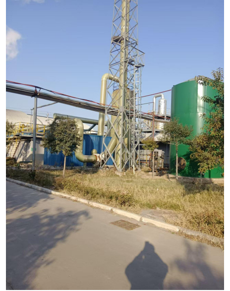
项目北侧-现有工程污水处理站
