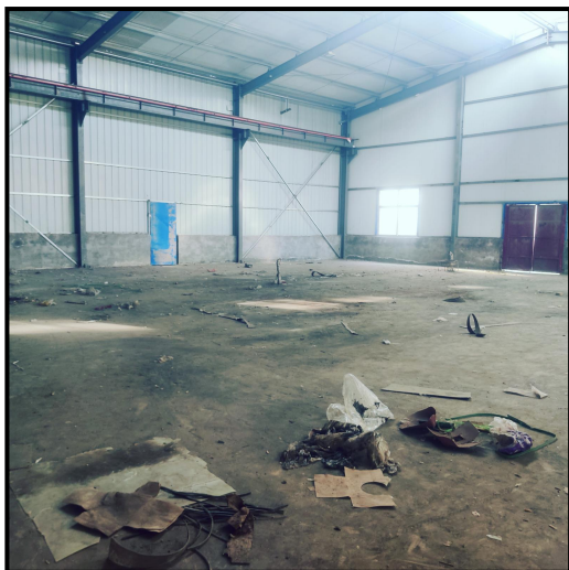
2#生产车间现状
