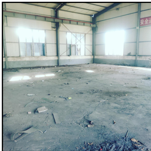
1#生产车间现状
