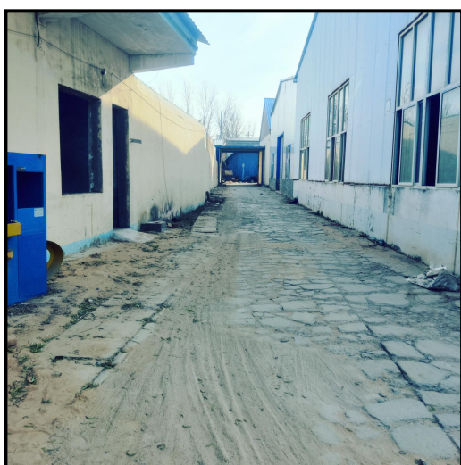
东侧办公用房及进厂道路
